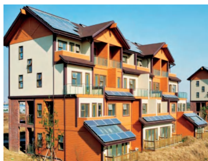
上下混合木结构建筑
